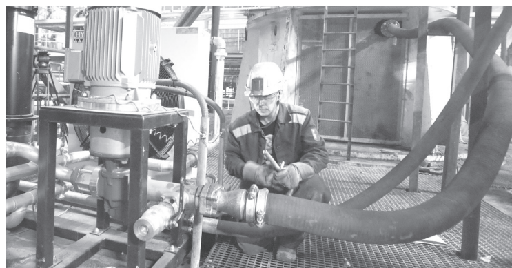
Специалисты «ННР» проводят ремонты на всех площадках Норильского дивизиона
