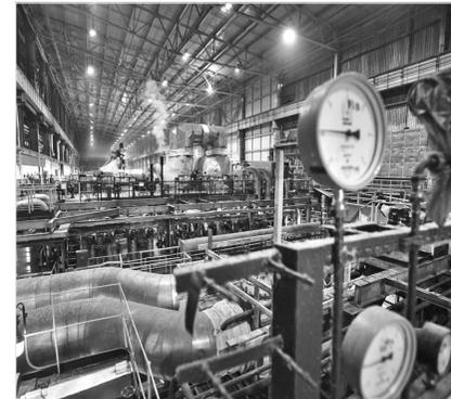
Норильские энергетики готовятся к зиме. На ТЭЦ-3 «Норильскникельремонт» ведет плановый ремонт турбоагрегата №2. Там же продолжается крупный ремонт поверхностей нагрева водогрейного котла. В прошлом году полностью заменили экраны котла – свыше 120 тонн, сейчас ведут замену конвективной части – около 250 тонн. Половина работ уже выполнена, полностью ремонт завершат в середине сентября.
