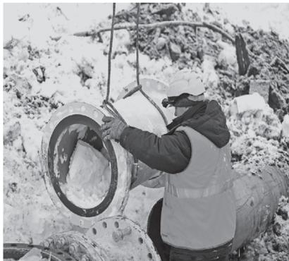
На Надеждинском металлургическом заводе идет ремонт резервного пульпопровода. Уже выполнено 97 процентов от намеченного плана. Сроки окончания работ – 30 ноября. Параллельно с ремонтом ведется изоляция трубопровода минераловатной плитой и жестью. Ремонтные работы производит Ремонтно-строительный трест «Норильскникельремонт». Монтаж ведут четыре независимых участка в разных местах.
