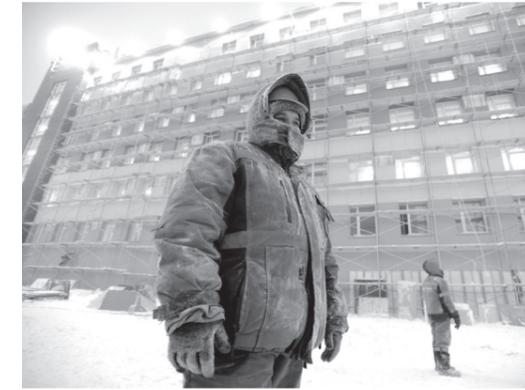
Фасады Надеждинского металлургического завода «одевают» в утепленные огнестойкие фиброцементные плиты «Краспан». Работы выполняет подрядчик из Красноярска – ООО «Руфас». Нашли его совместно управление главного механика ЗФ с ООО «Норильскникельремонт». Красноярцы специализируются на монтаже навесных фасадов и проводили работы даже на Шпицбергене.
